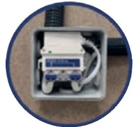
Installazione in scatola di giunzione 80x80mm
